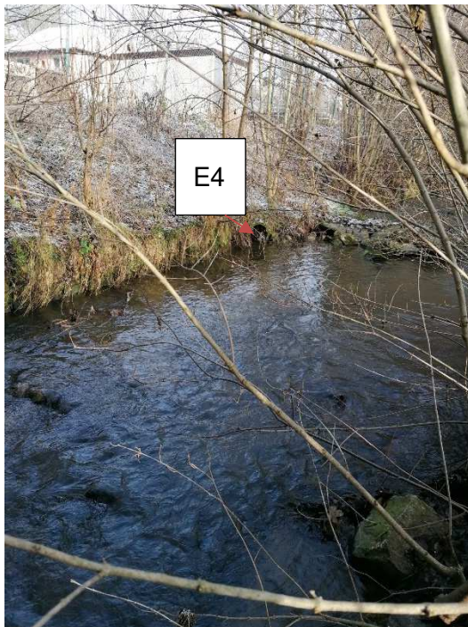
Abbildung 7: Einleitstelle E4 ,keine Grobstoffe erkennbar
