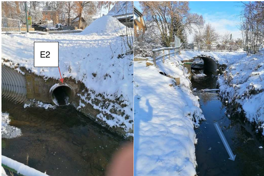
Abbildung 14: Blick gegen die Fließrichtung unterhalb der Einleitstelle E6/E2
