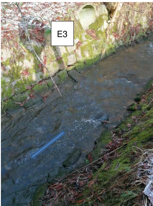
Abbildung 6: Einleitstelle E3, Böschung und Sohle mittels Wasserbaupflaster befestigt
