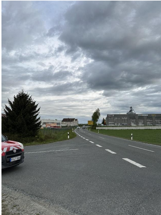
Abb. 18: Einleitungsstelle 5 – Einzugsgebiet Gewerbegebiet
