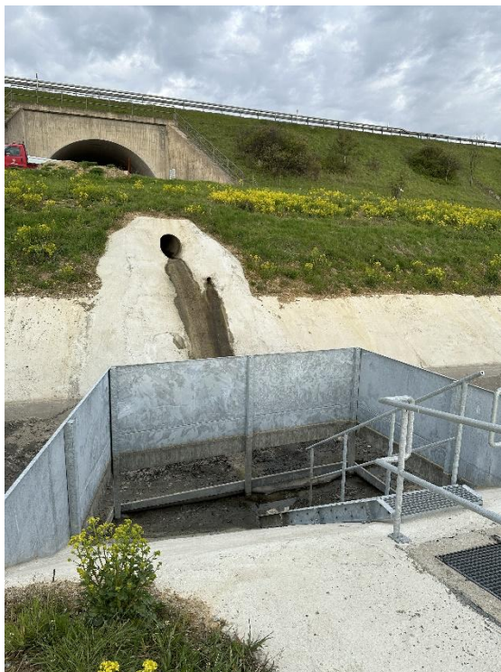
Abb. 24: Einleitungsstelle 6 – Einlauf RRB
