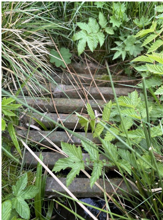
Abb. 29: Einleitungsstelle 7 – Einlauf Verrohrung
