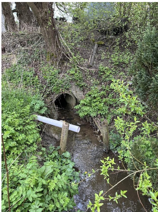
Abb. 17: Einleitungsstelle 4 – Ende Bachverrohrung
