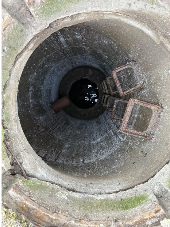
Abb. 21: Einleitungsstelle 5 – Sickerschacht
