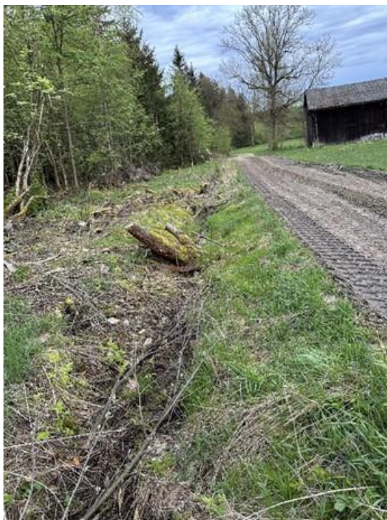
Abb. 8: Einleitungsstelle 2 – Grabenverlauf nach Einleitungsstelle
