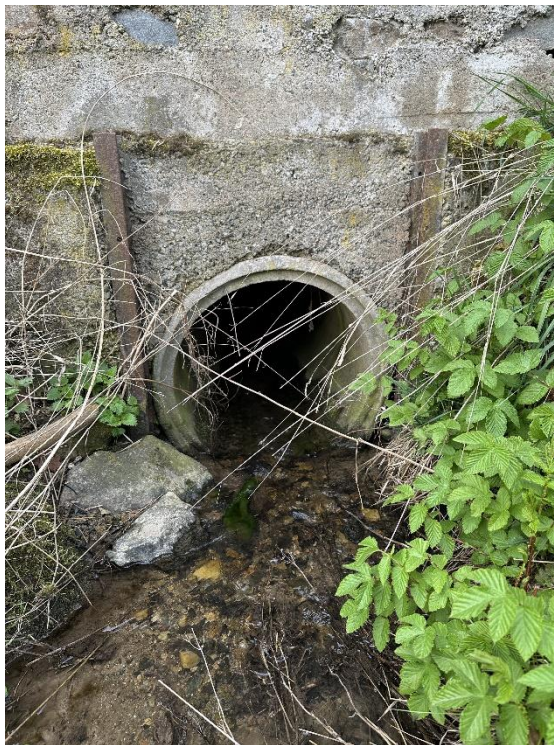
Abb. 16: Einleitungsstelle 4 – Beginn Bachverrohrung
