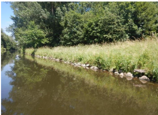
Abb. 49: Geradlinige Uferlinie mit Blocksteinen in UA 1
