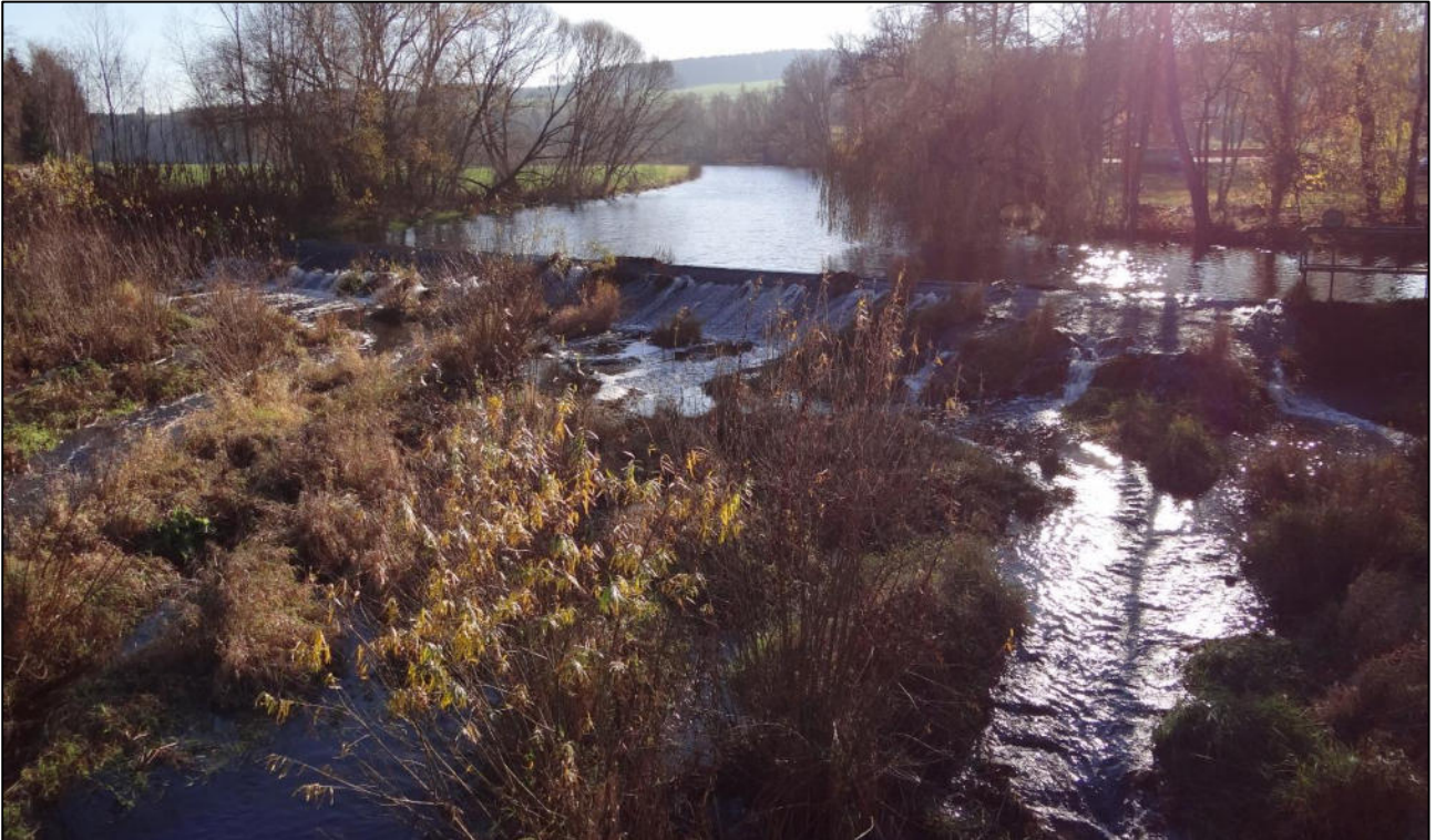
Abb. 53: Sächsische Saale bei F-km 24,07 – Wehranlage der WKA „Joditzmühle“; Blick flussaufwärts
