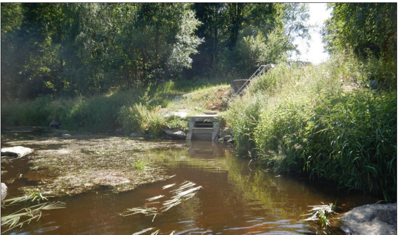
Abb. 36: Sächsische Saale bei F-km 28,37 – Wasserentnahmebauwerk der Firma Macher; Blick flussaufwärts
