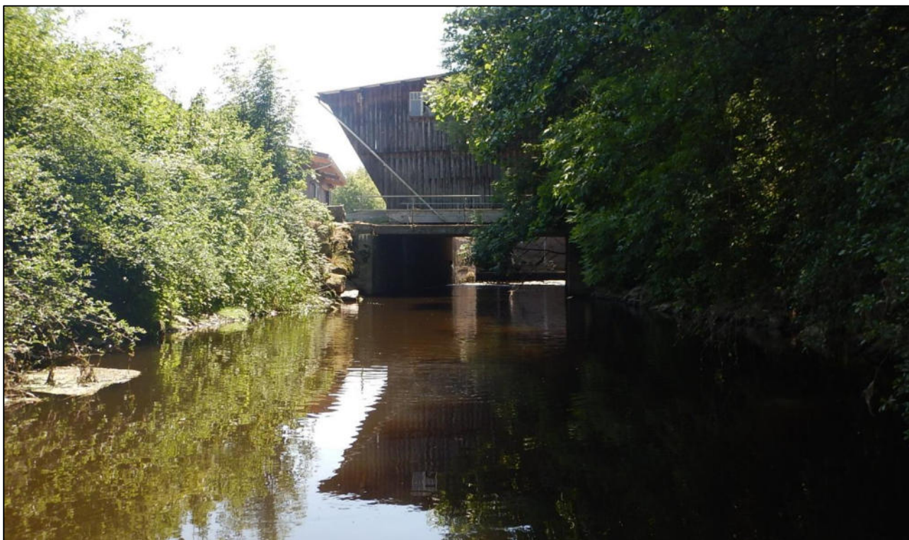
Abb. 55: Sächsische Saale bei F-km 23,96 – Turbinenhaus der WKA „Joditzmühle“; Blick flussaufwärts
