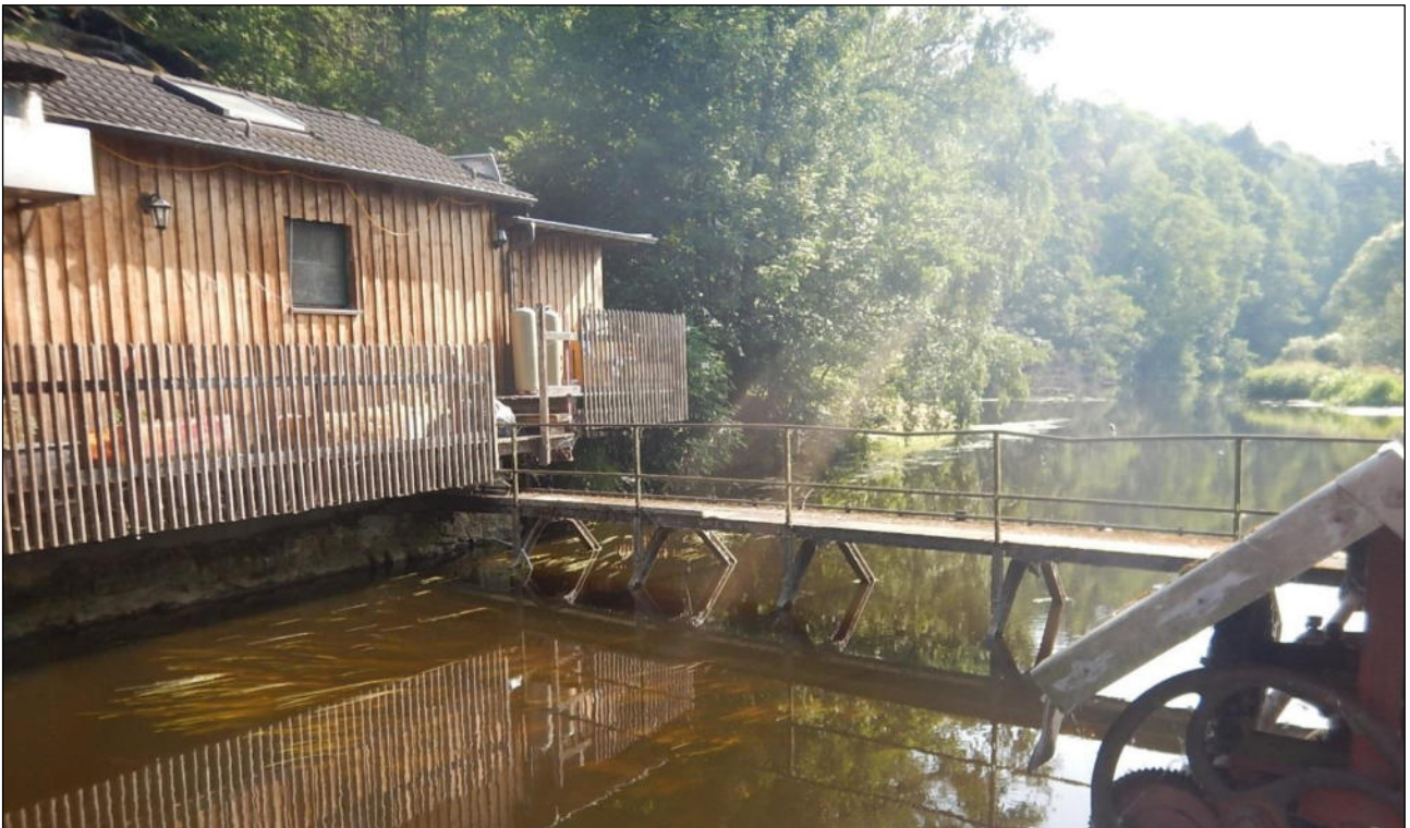
Abb. 45: Sächsische Saale bei F-km 26,02 – Triebwerkskanal und Stauraum der WKA „Fattigsmühle“; Blick flussaufwärts
