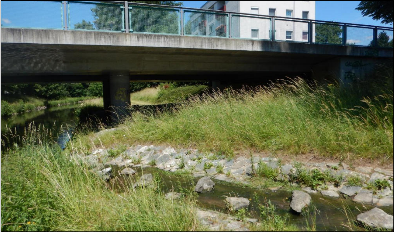
Abb. 1: Sächsische Saale bei F-km 32,95 – Einmündung Krebsbach; Blick flussabwärts
