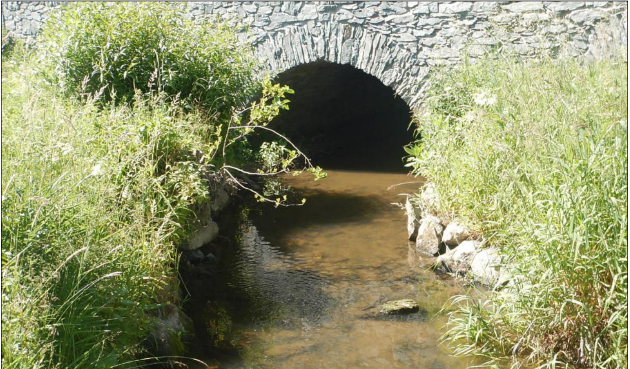
Abb. 69: Göstra bei F-km 1,16 – Straßenbrücke der Staatsstraße 2192; Blick flussaufwärts
