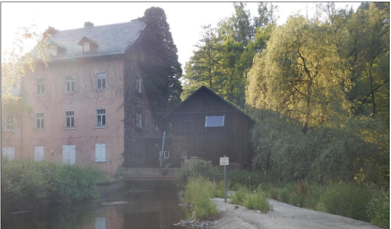
Abb. 64: Sächsische Saale bei F-km 19,95 – Turbinenhaus und Rechenanlage der WKA „Lamitzmühle“; Blick flussabwärts
