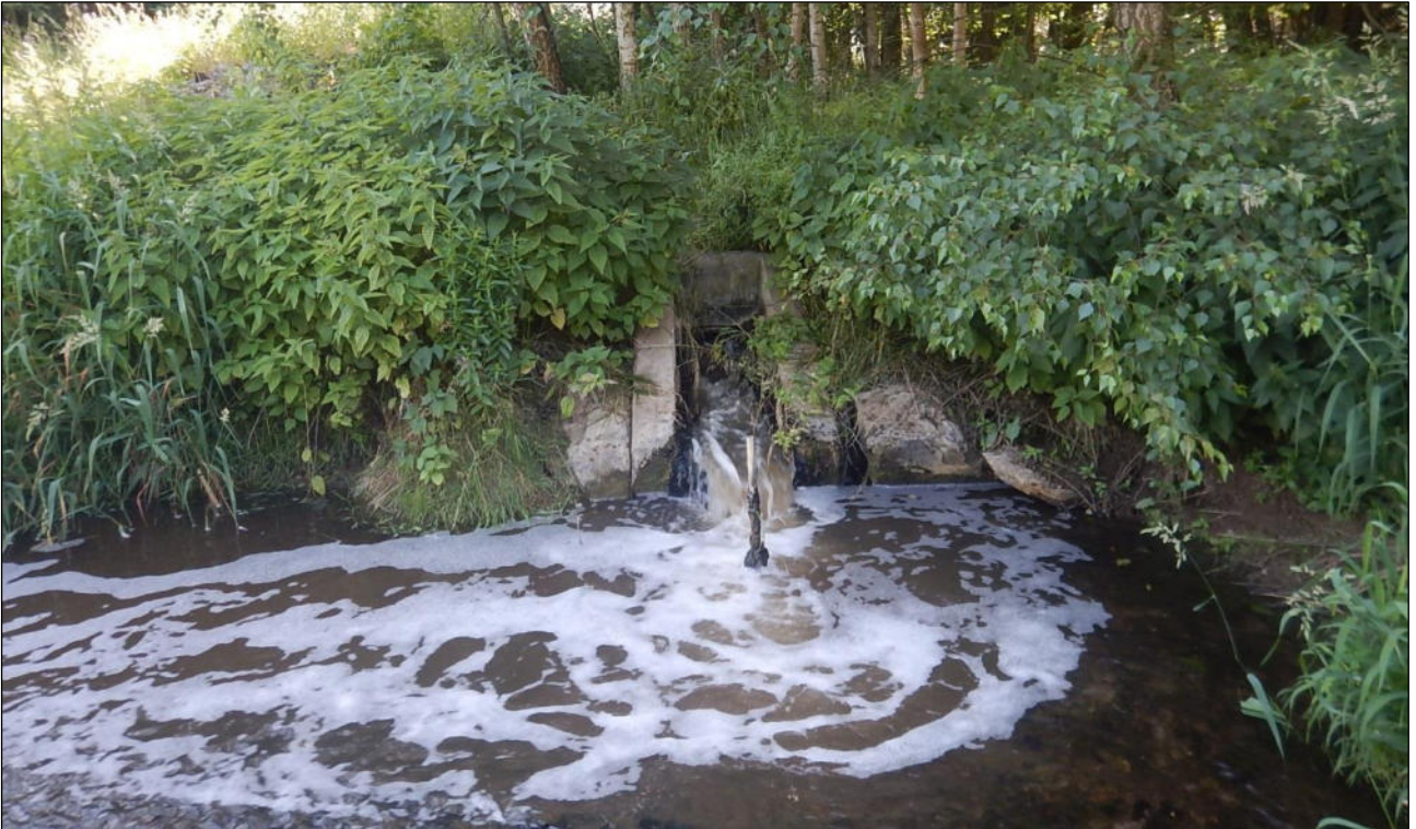
Abb. 37: Sächsische Saale bei F-km 28,36 – Abwassereinleitbauwerk (Kläranlage) der Firma Macher
