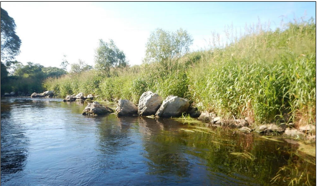
Abb. 18: Sächsische Saale von F-km 30,96 bis 31,02 – Felsbühnen mit dazwischenliegenden strömungsberuhigten Bereichen; Blick flussabwärts
