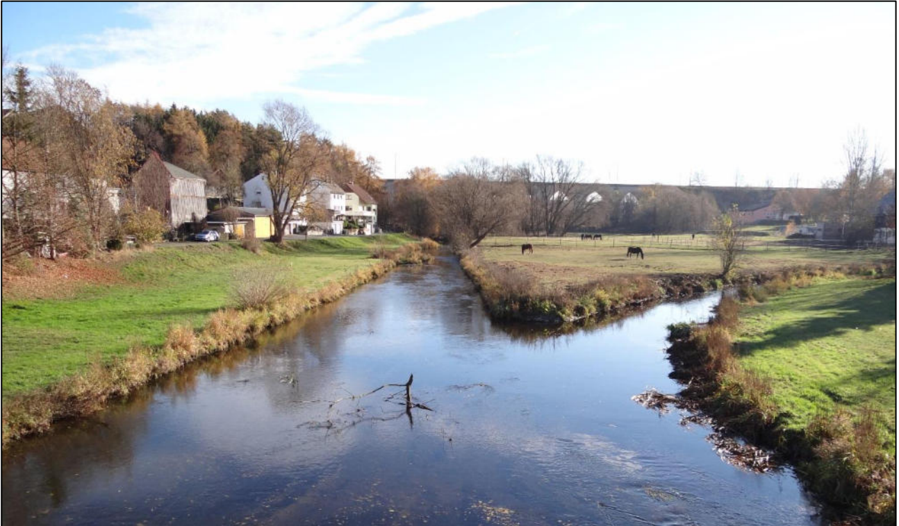
Abb. 13: Sächsische Saale bei F-km 31,72 – Einleitung der Kläranlage Hof (rechts) in die Sächsische Saale (links); Blick flussaufwärts
