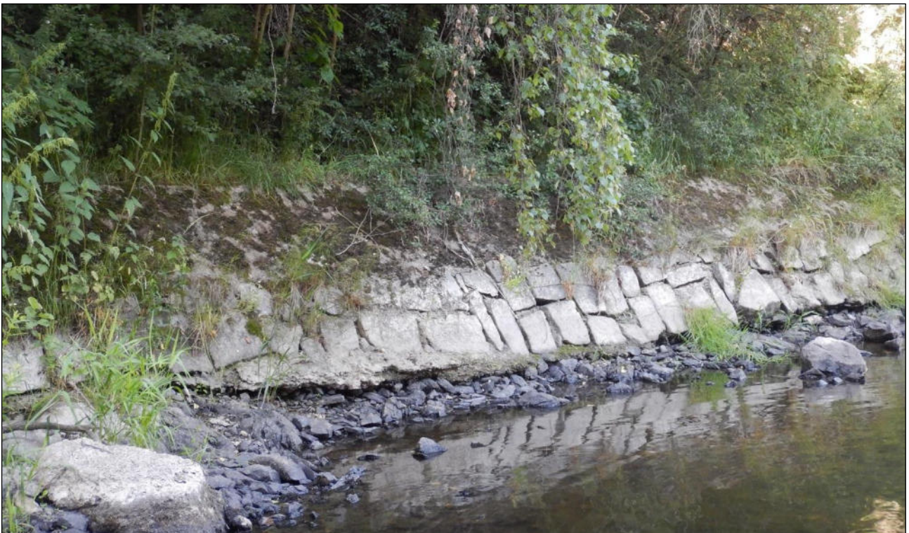
Abb. 10: Sächsische Saale bei F-km 31,97 – Ufersicherung aus betoniertem Blocksteinsatz (rechtes Ufer)
