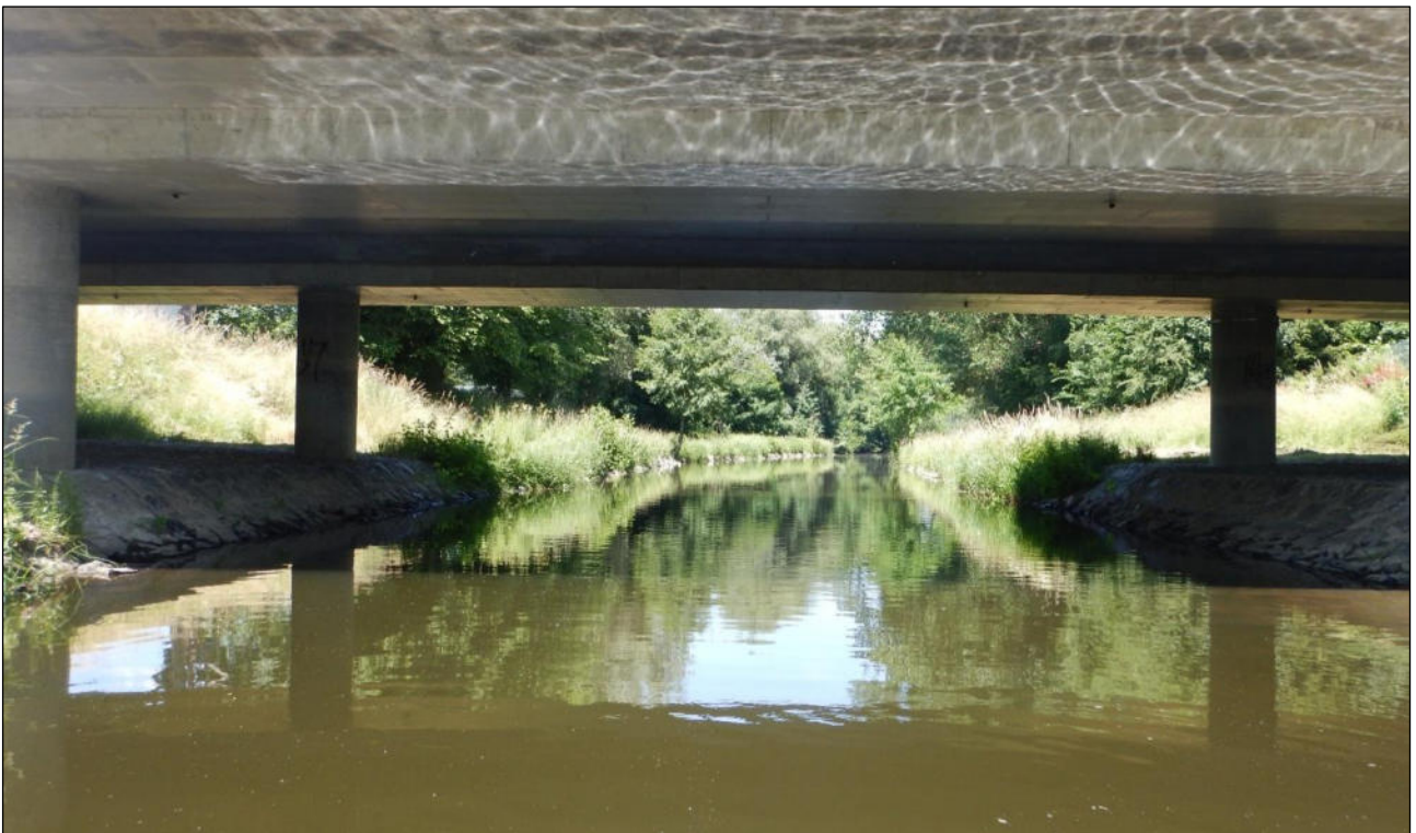
Abb. 2: Sächsische Saale bei F-km 32,95 – Straßenbrücke Krebsbachweg; Blick flussabwärts
