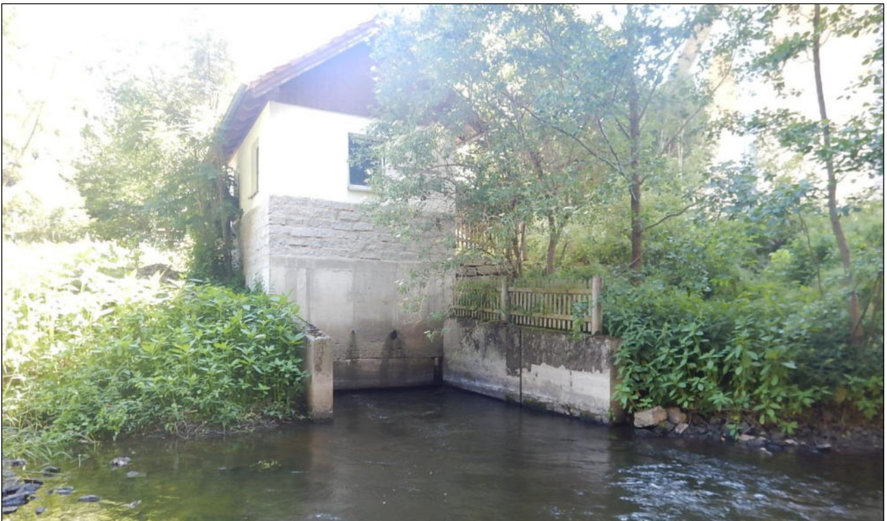
Abb. 8: Sächsische Saale bei F-km 32,02 – Turbinenhaus der WKA „Obere Mühle“ Blick flussaufwärts
