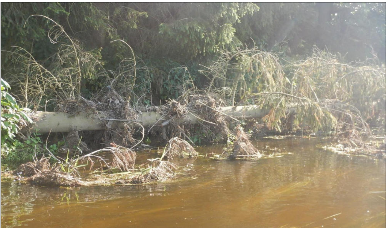
Abb. 58: Sächsische Saale bei F-km 22,46 – Totholz (linkes Ufer)
